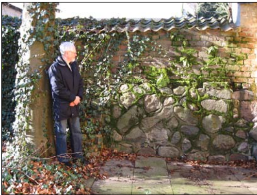
Abb. 1: Rest der Stadtmauer (Innenseite) im Garten der Kirchengemeinde St. Nikolai
